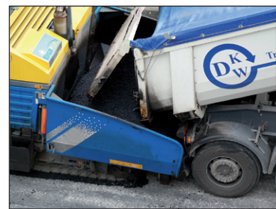
Figuur 3.13 – Laden van een asfaltspreidmachine
