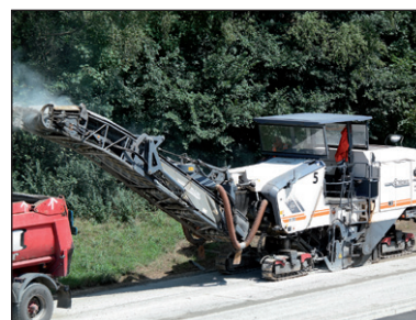
Figuur 3.4 – Grote freesmachine
