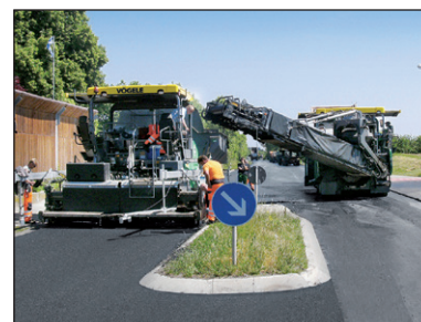
Figuur 1.56 – Zijdelingse aanvoer met tussenhopper
