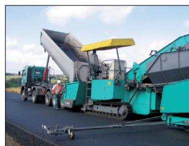
Figuur 3.30 – Baangeleiding van de asfaltspreidmachine
