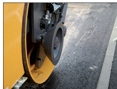
Figuur 3.45 – Verdichting met behulp van een kantrol
