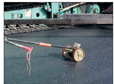
Figuur 5.4 – Aan de asfaltspreidmachine vastgehaakt meetwiel voor de afgelegde afstand
