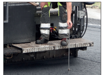
Figuur 5.3 – Nameten van profiel en niveau aan een gespannen draad
