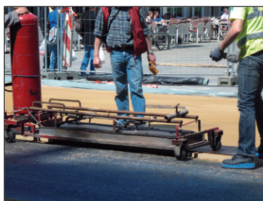
Figuur 3.44 – Gebruik van een verwarmingsbalk om asfaltranden te verwarmen
