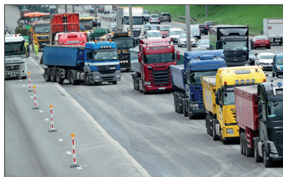
Figuur 2.4 – Te veel vrachtwagens op de bouwplaats
