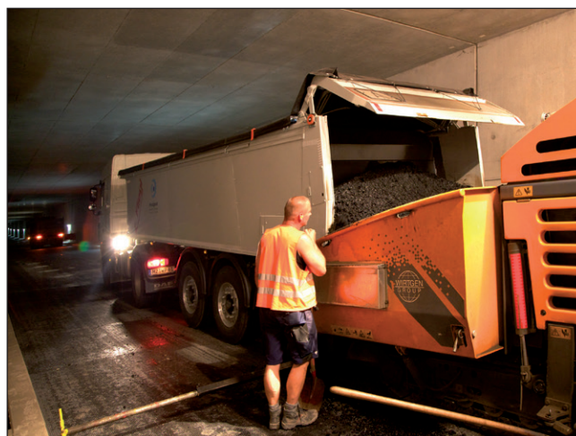
Figuur 1.1 – Laadbak met afschuifstelsel
