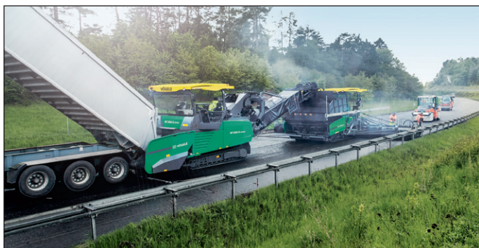
Figuur 1.54 – Aanbrengen van asfalt met een tussenhopper
