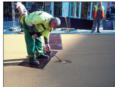
Figuur 4.6 – Gebruik van houten planken
