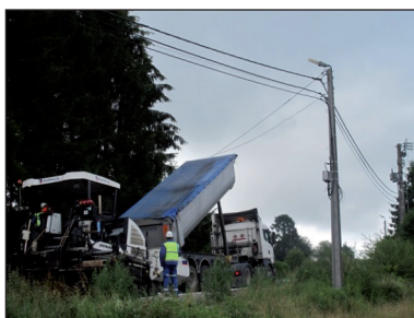
Figuur 2.1 – Gevaar door electriciteitskabels
