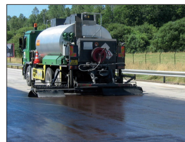
Figuur 3.6 – Aanbrengen van een kleeflaag
